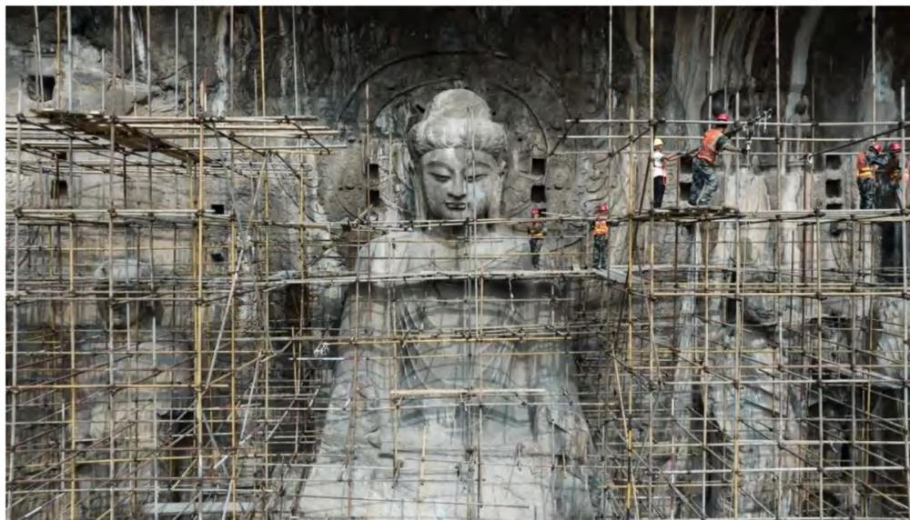
(奉先寺保护工程完成，正在拆除施工脚手架)
