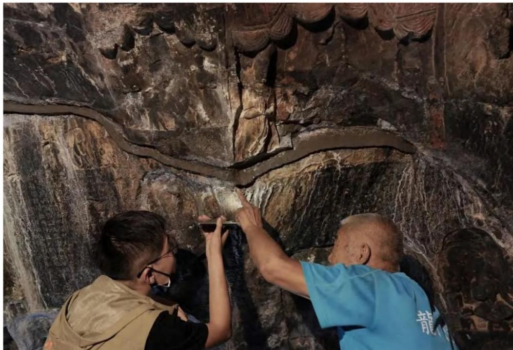
(古阳洞内施工人员处理洞窟顶部渗漏水问题)
